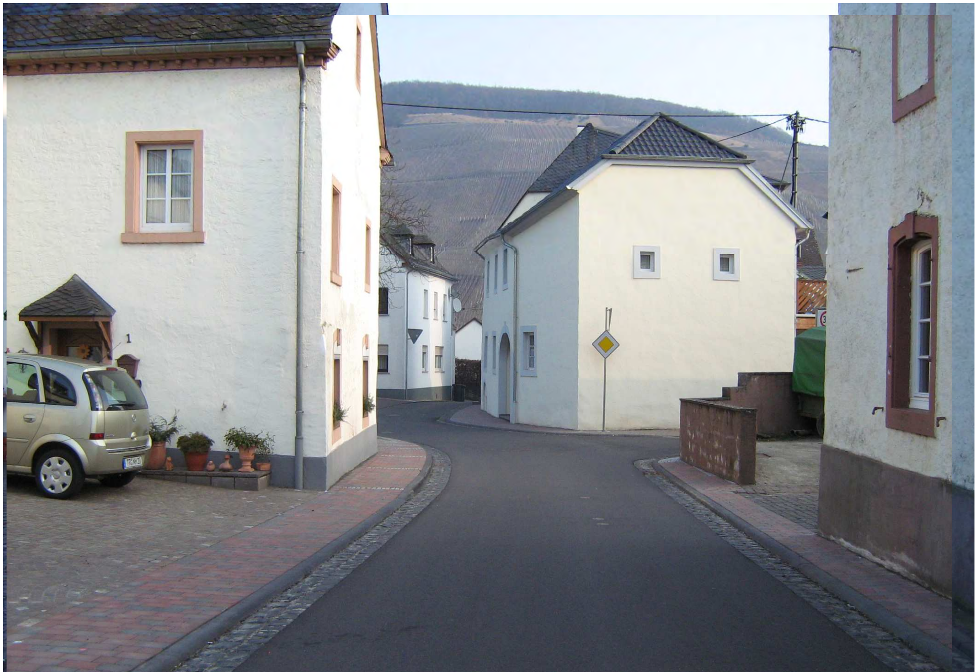
Beispiel einer ausgebauten Ortsdurchfahrt in Longuich
